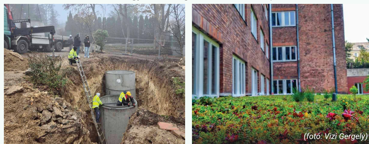
Vízmegtartó megoldások Hegyvidéken: ciszternák a Diana utcában és zöldtető a Hegyvidéki Polgármesteri Hivatal épületén
